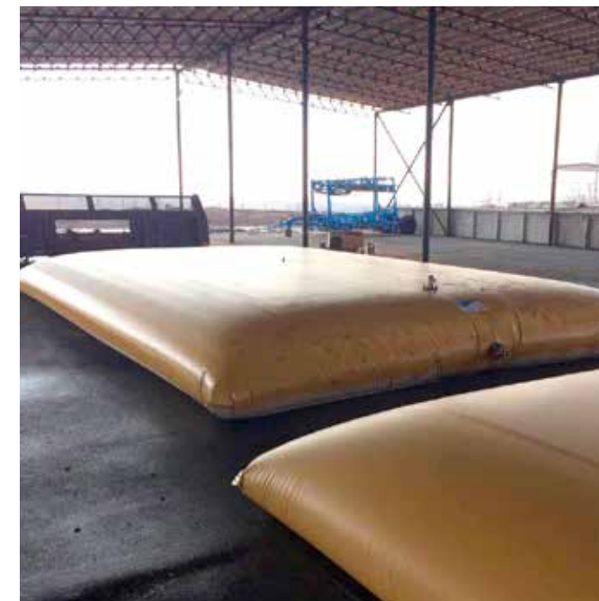
СКЛАД ХРАНЕНИЯ КАС ИЗ 2-Х ГИБКИХ РЕЗЕРВУАРОВ ОБЩИЙ ОБЪЕМ - 100 м 3
